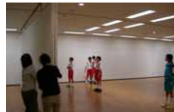
広い空間に壁を出して、展示スペースが作られていきます
