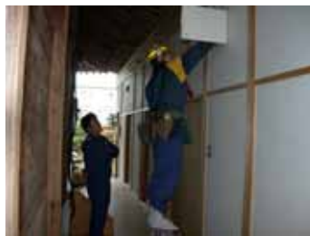
高家寺(漏電のチェック)
